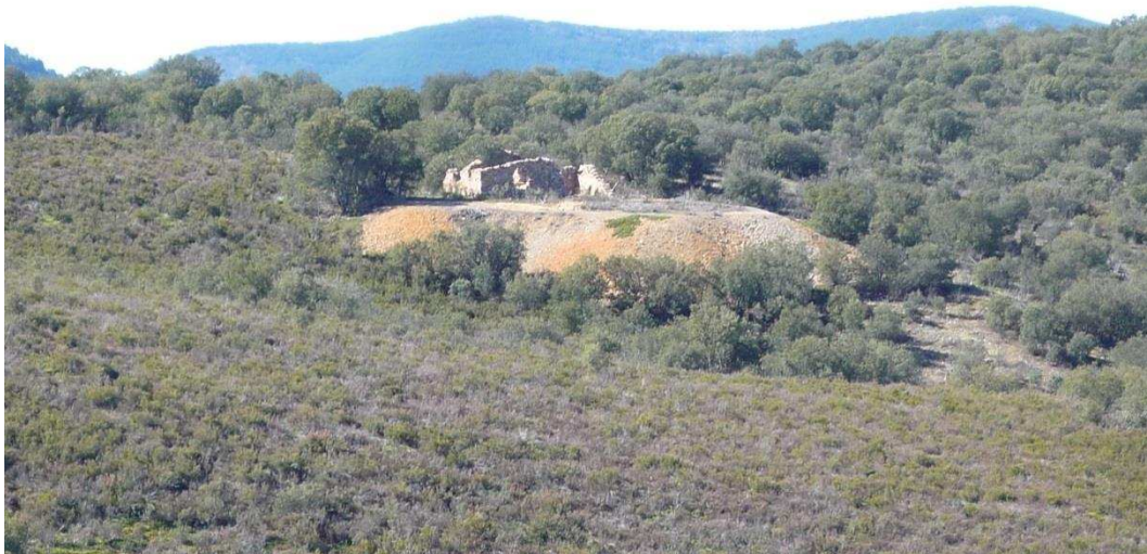
Ilustración 4 Restos de edificaciones y escombrera de la mina "Paquita" (Foto del autor, 2015).
